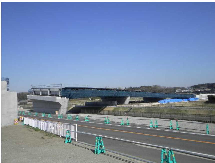
県道22号 新用田橋新設(上部工)工事
