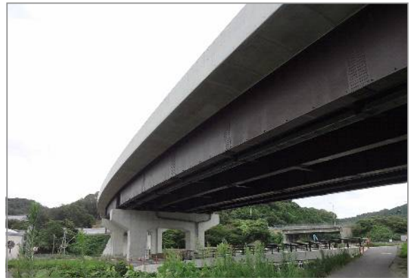
一般国道473号 本宿高架橋上部工事
