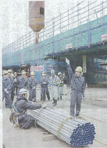
用いられる手延機のボルト締めのほか、足場
