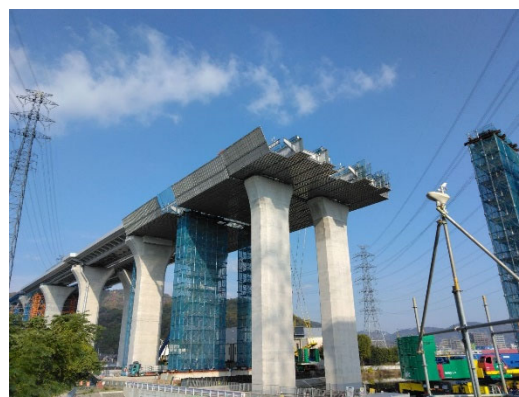
床版施工用の吊足場に組換完了
