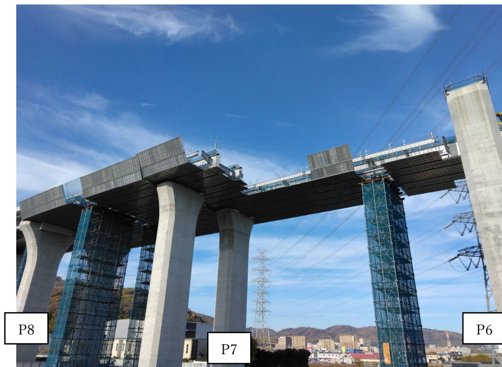
進捗写真（上り線：P8～P6架設完了、下り線：P8～P7架設完了）
