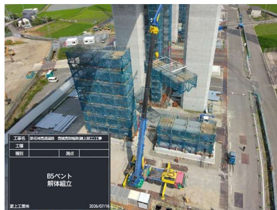
「ユニットベントとして転用組立」
