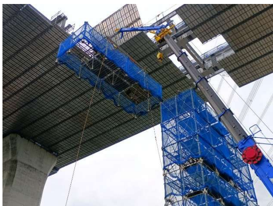
「頂部ユニットベントの解体」
