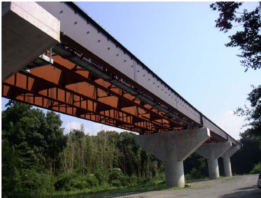
下山B P 高屋川橋鋼橋上部工事
