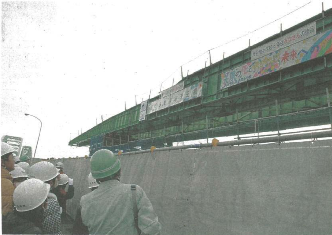
子どもたちの横断幕が掲げられた架け替え工事現場
