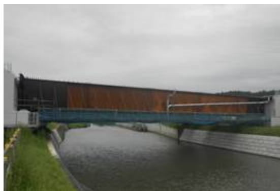
上北地区橋梁上部工工事
