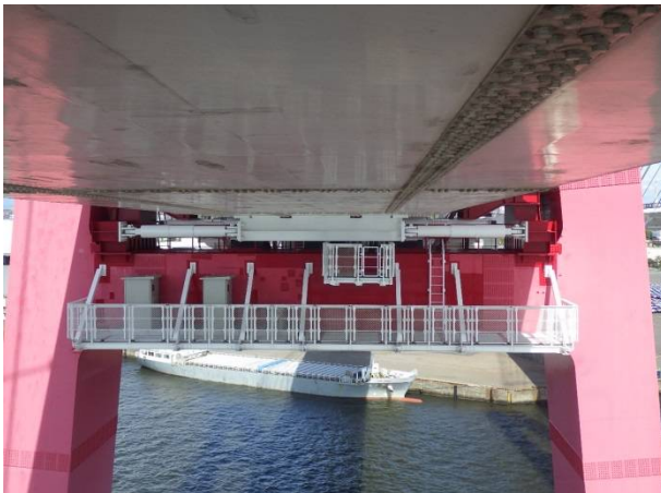
主塔部（中央径間側）：橋直ダンパー、負反力対策構造等
