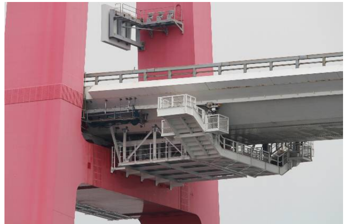
主塔部（側径間側）：橋軸ダンパー、検査車改造等
