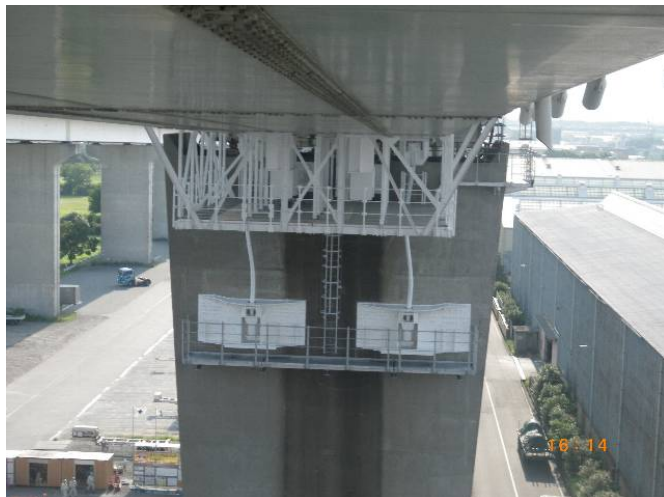
主塔部（中央径間側）：橋直ダンパー、負反力対策構造等
