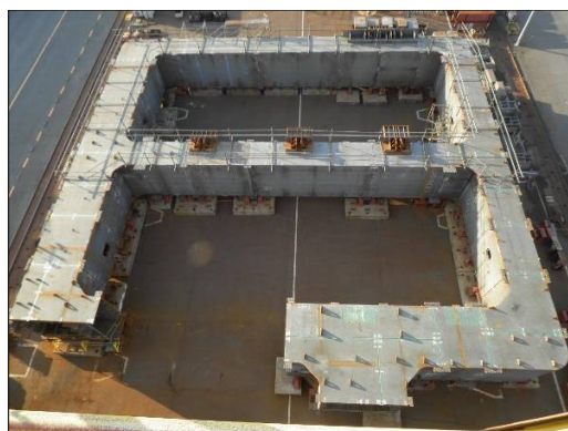
PH本18橋脚 仮組立全景
