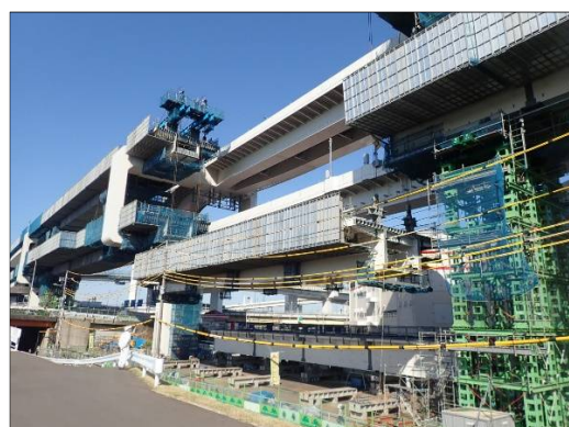
第4径間 吊上架設状況
