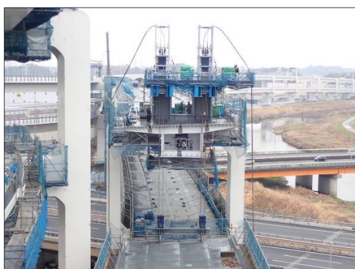
吊上架設設備
