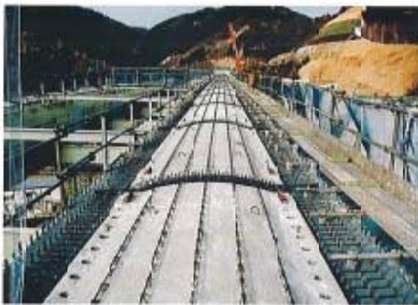
開断面給排水の上フランジ部に設置した例
