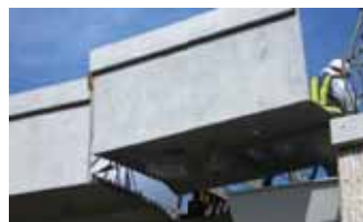
施工風景(合成床版に先付け施工)
