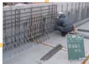
② 壁高欄内部の鉄筋を組立てます。
