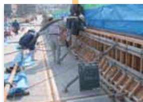
⑤ コンクリートを打設して、養生します。
