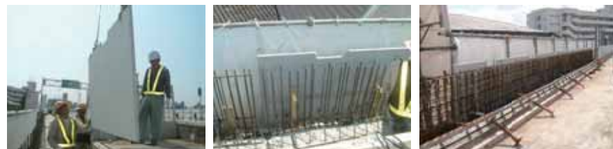
①取付作業
