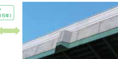
PCF壁高欄での施工例(※)
