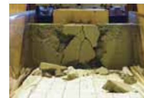
場所打ち壁高欄
