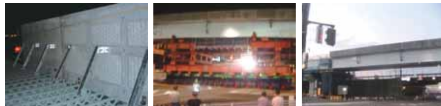
④PCF版の設置完了
