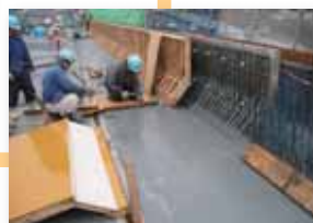
④ 内側の型枠 (木製型枠) を組立てます。
