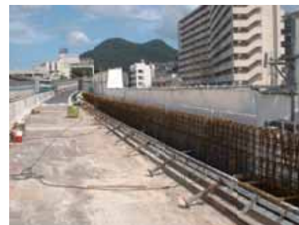
高欄の取り替え工事の施工例
