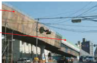
国土交通省中国地方整備局(広島県内)での施工例(※)
