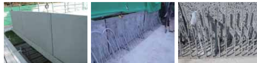
④設置状況（外面）
