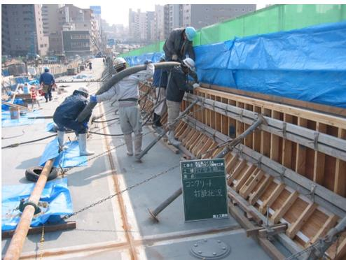
写真 - 8 コンクリートの打ち込み
