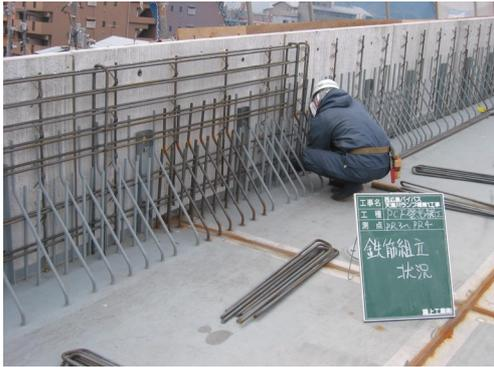
写真 - 6 内側鉄筋の配筋
