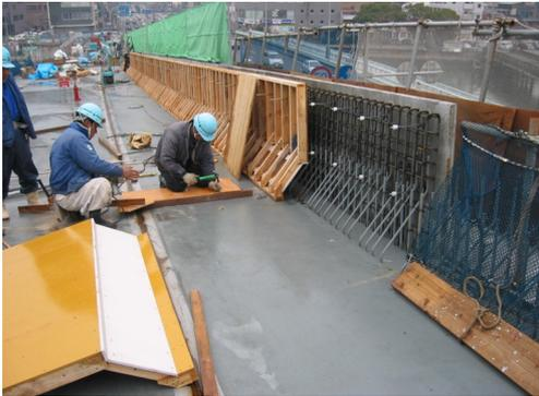
写真 - 7 内型枠の設置
